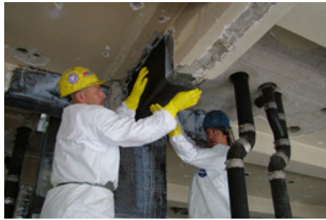
Σχήμα 3: Διαδικασία τοποθέτησης υφάσματος FRP σε δομικά μέλη[5]
