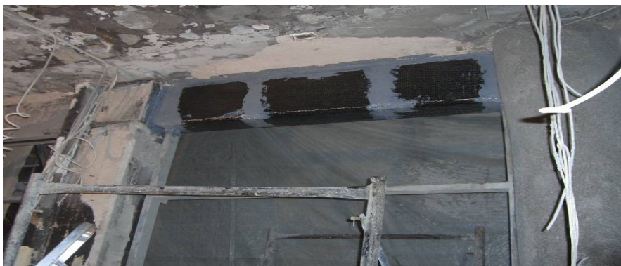
Σχήμα 4: Ανοιχτή μέθοδος ενίσχυσης U-shape σε υφιστάμενη δοκό [8]
